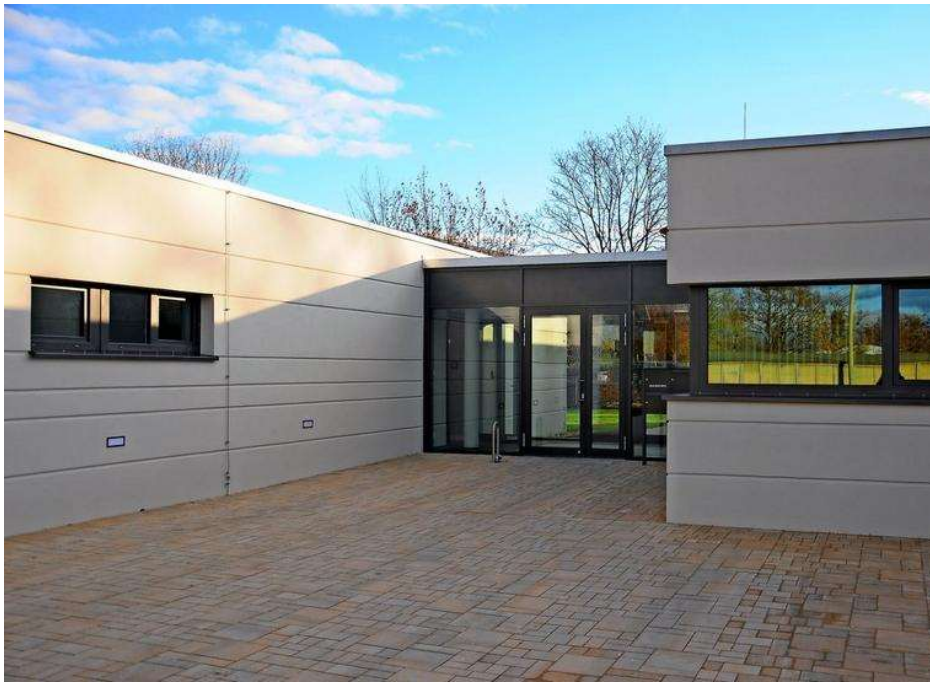
Nach 15 Monaten Bauzeit wurde das Hospiz in Wittenberge am 22. Januar 2021 offiziell eröffnet. Quelle: Stephanie Fedders
